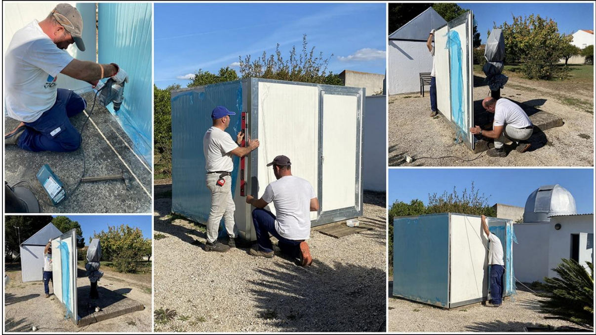
Figura 6 – Observatório de tecto de correr (instalação das paredes laterais).
