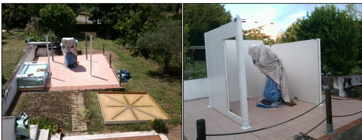
Figura 2 – Fases da construção; tampa e prumos verticais (esquerda), painéis instalados - sul, este e norte, este último já com a “porta cortada” (direita). Verão de 2018.
