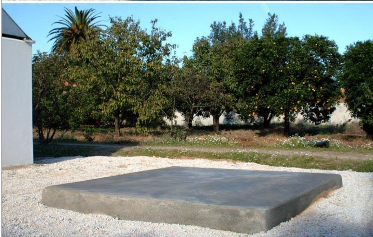
Figura 3 – Plataforma 2x2 m.
