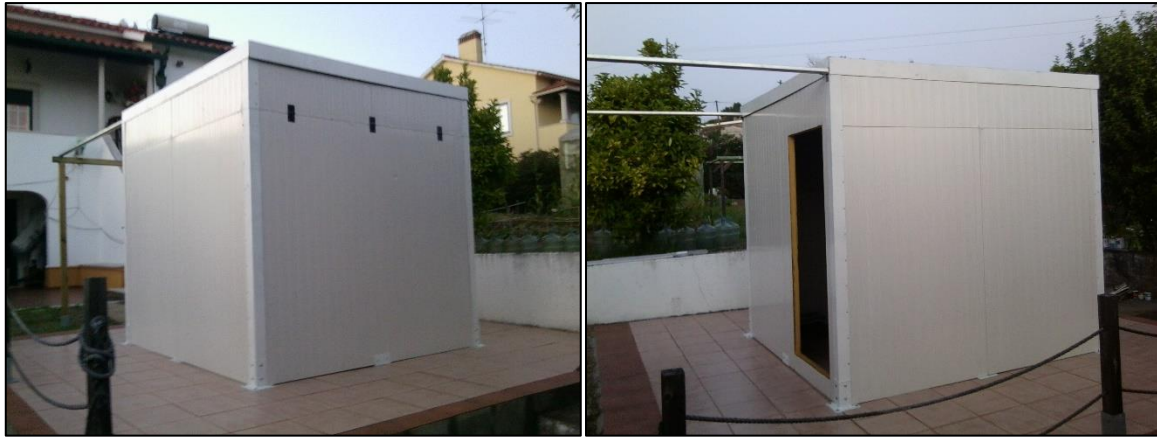
Figura 3 – Fases da construção; vista de SW (esquerda), vista de NW (direita). Verão de 2018.
