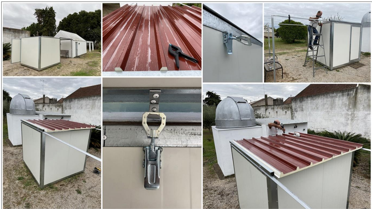
Figura 7 – Observatório de tecto de correr (instalação do telhado - Roofmate).
