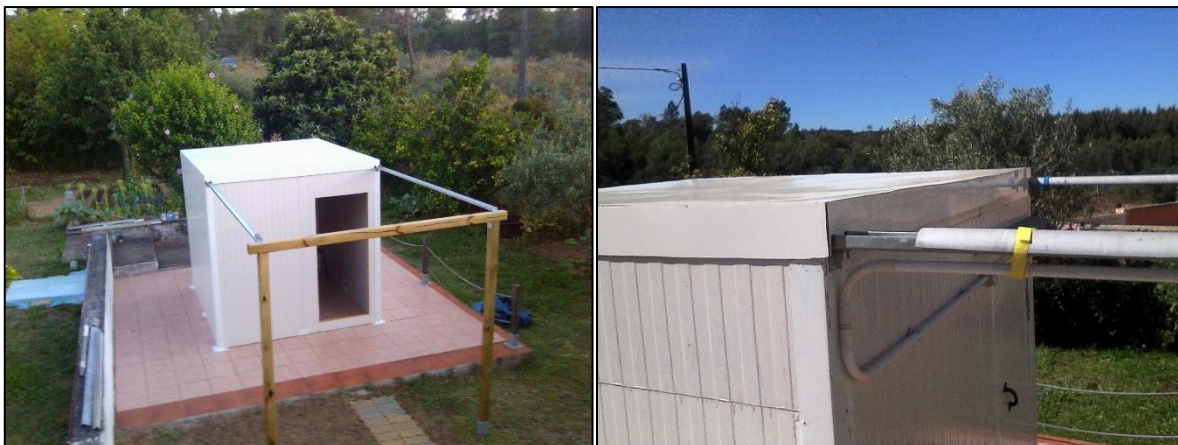
Figura 4 – Fases da construção; vista de N, suporte das calhas (esquerda), detalhe das calhas e sua protecção, instalação eléctrica exterior (direita). 2018.
