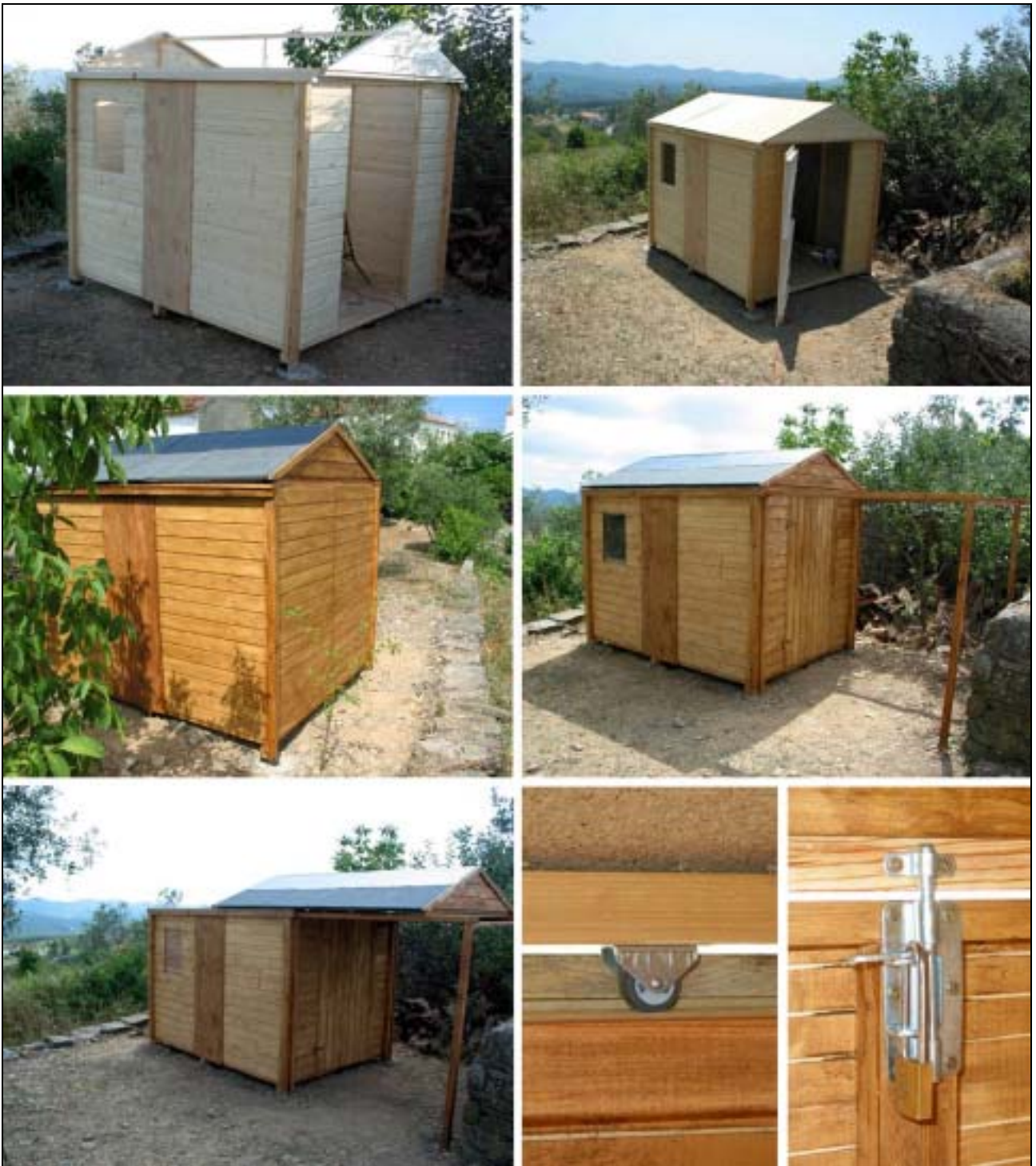
Figura 1- Observatório de tecto-de-correr construído por Fernando Delgado ( fmd@inforbase.pt ). Adaptação de um abrigo de jardim (AKI).
