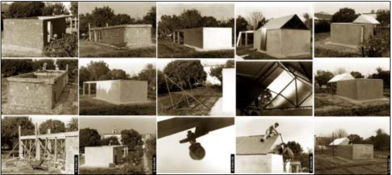
Figura 8- Observatório de tecto-de-correr construído por Pedro Ré (1978).
