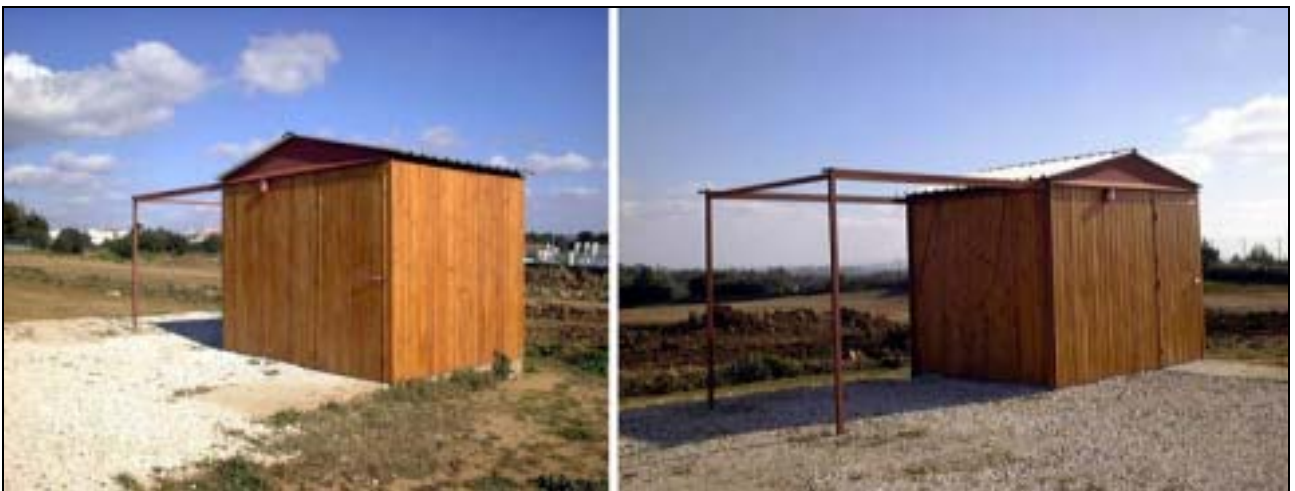
Figura 7- Observatório de tecto de correr (Centro de Medicina de Reabilitação de Alcoitão).
